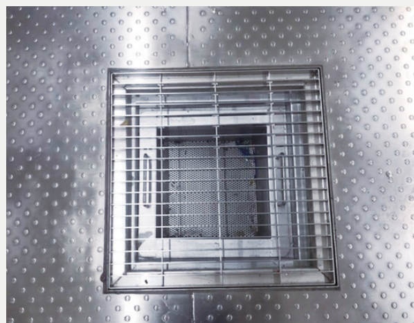
工場排水溝まわり Factory drainage gutters
