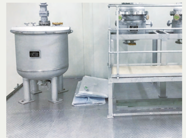
工場内床 Factory floors
