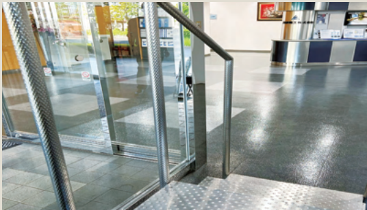
屋内手すり Indoor handrail
